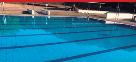
Coronació i vas piscina municipal (22.000 €)
