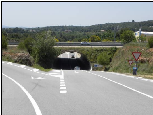
Fotografia 3.1.7 – Pas inferior B-112 (costat Nord).
