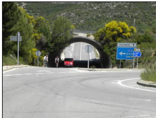
Fotografia 3.1.8 – Pas inferior B-112 (costat Sud).
