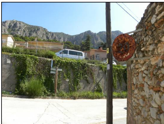
Fotografia 6.1.4.1 – Senyal deteriorada al Pujolet.
