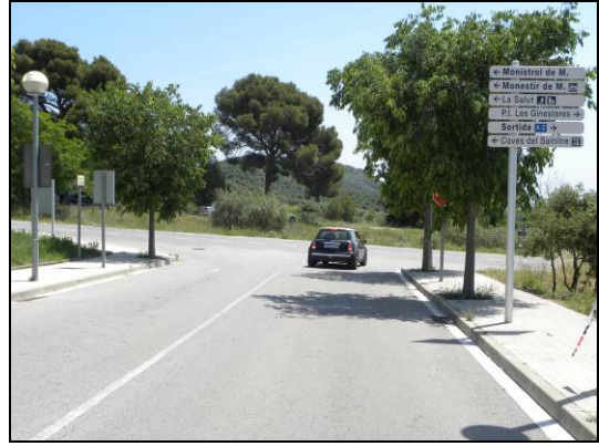
Fotografia 6.1.4.4 – Senyalització de STOP no visible.
